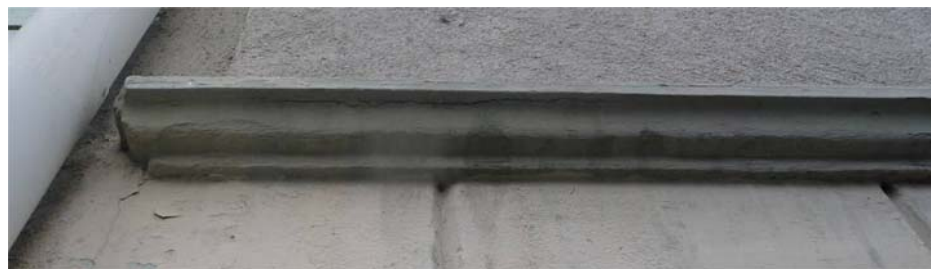
Abbildung 9 Detail Stockgurt
