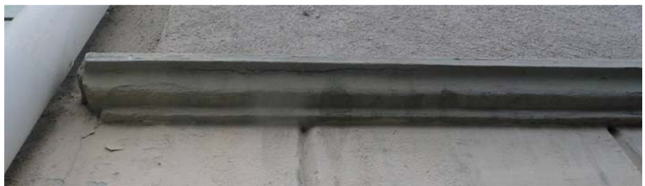
Abbildung 9 Detail Stockgurt
